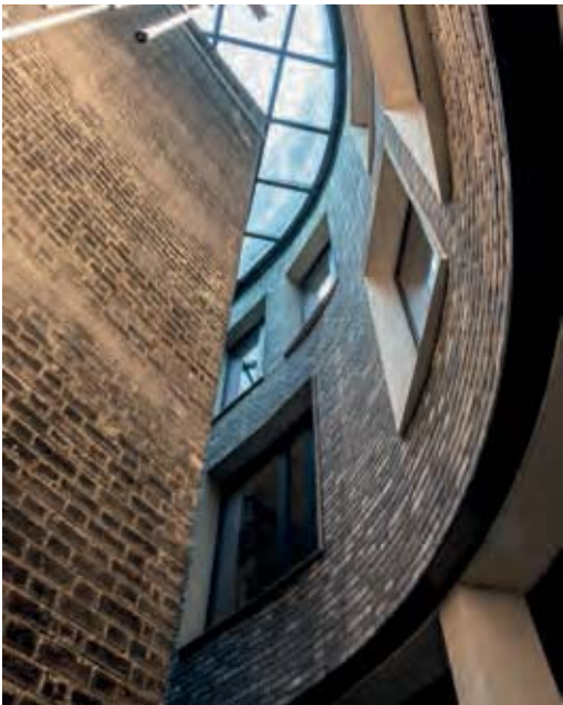
Det kurvede, nye rum mellem Stanley bygningen og den nye bygning er ovedækket med glas.
