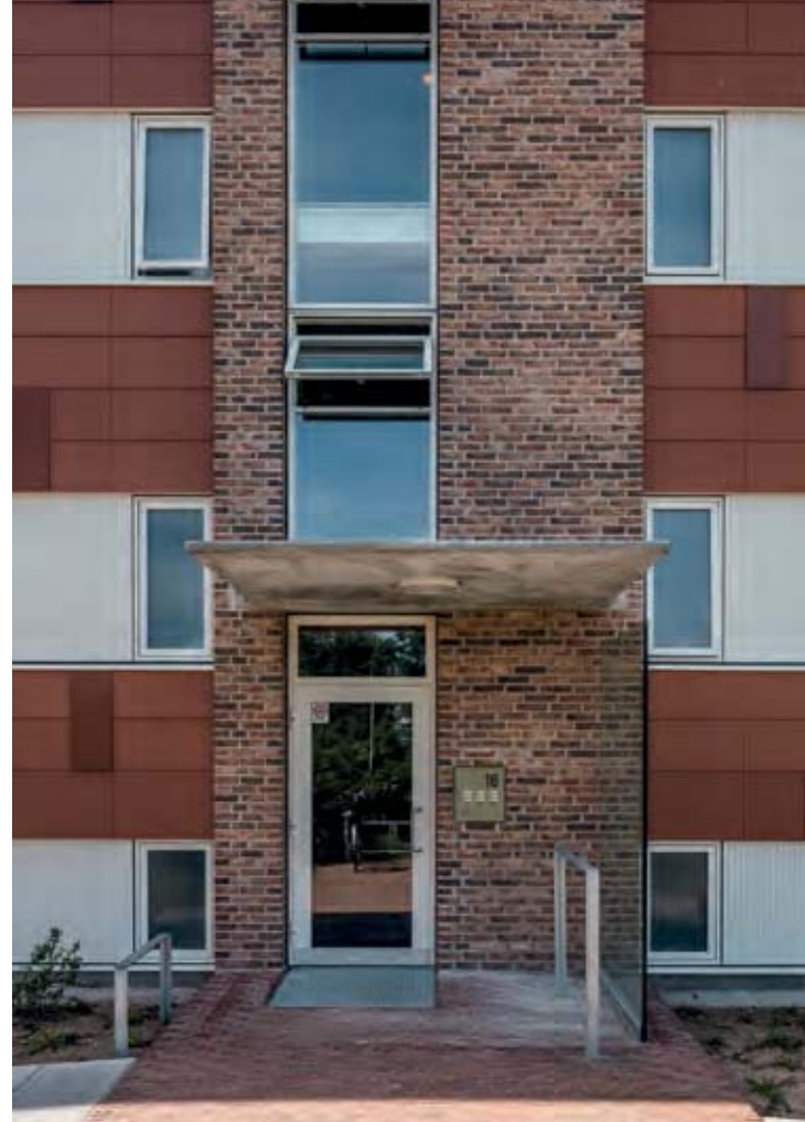
Blokkenes indgange blev ombygget og er nu markeret med et murværksparti og en belægning af hårdtbrændte sten, der som et tæppe løber hen over stien langs blokken.
