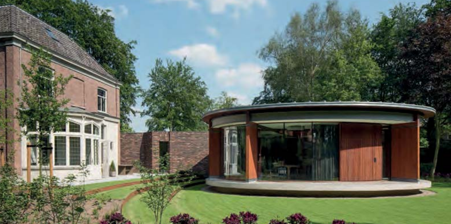
For at kunne fungere som en moderne virksomhed blev 1800-tals villaen udvidet med en plekter-formet pavillon i træ og glas og en rektangulær bygning i mur.
