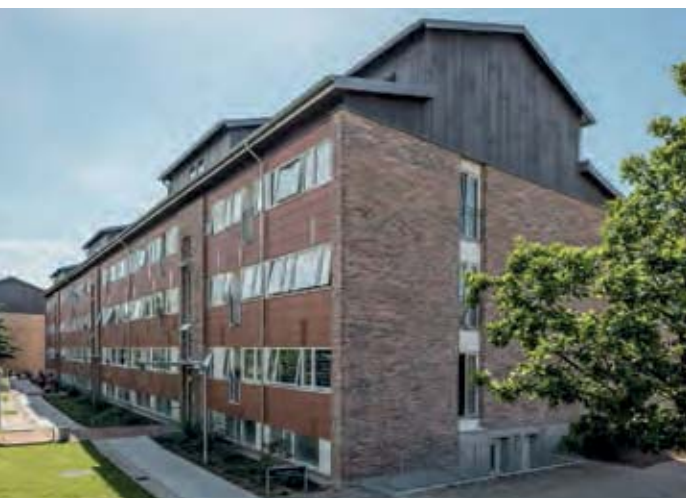
Arkitekterne fik specialindfarvet keramiske skærmlader i fire farver, der smukt matcher nuancerne i de fire mursten, der blev valgt til byggeriet.
