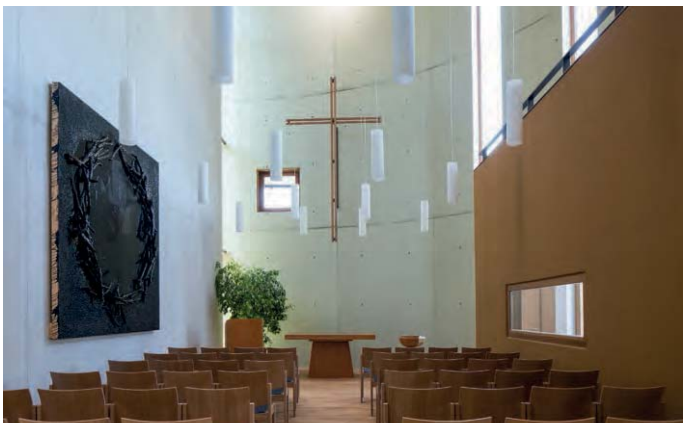
I kirkerummet, der rejser sig i højden mod alteret, står væggene i beton med tydelige spor efter forskallingen, men laseret i dæmpede farver, der er med til at understrege arkitekturens former.
