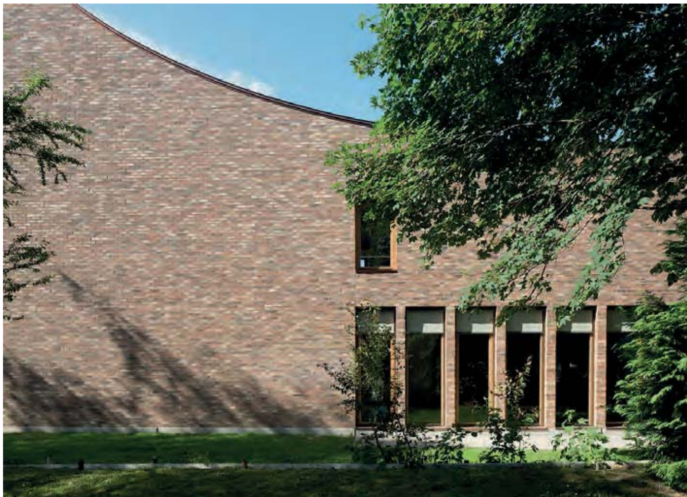
Tagets spændte kurve skaber kontrast til vinduernes stramme, rytmiske betoning af lodrette og vandrette linjer. Bygningens samlede form opleves som en indbydende gestus.
