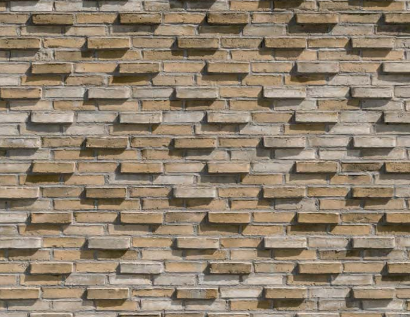
Nogle gavle er udført med relief, der er fremkommet ved at skubbe hver anden sten i et løberskifte lidt ud. Det skaber et rytmisk forløb, som opleves meget forskelligt afhængigt af gavlens placering i forhold til verdenshjørnerne og afhængigt af murstenenes farve.
