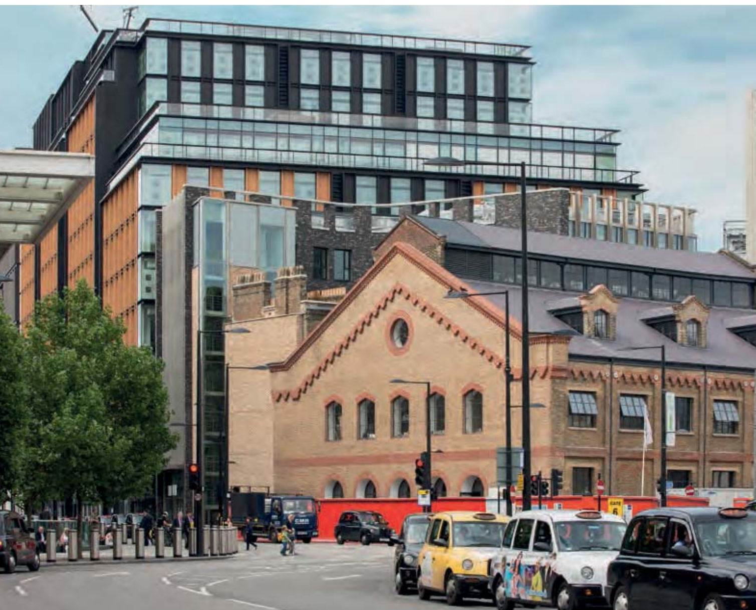
Opgaven lød på at skabe visuel og funktional sammenhæng mellem den nye kontorbygning og den fredede Stanley Building samt renovere sidstnævnte. Løsningen blev at krumme en murstensbygning rundt om det fredede hus.
