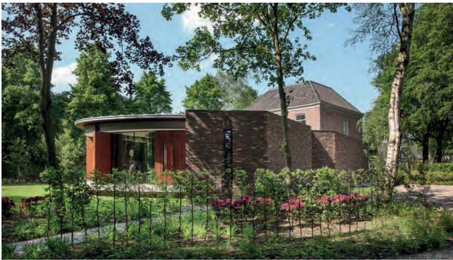
Begge tilbygninger er udført i en etage og skærmer dermed ikke for udsigten til den gamle villa.
