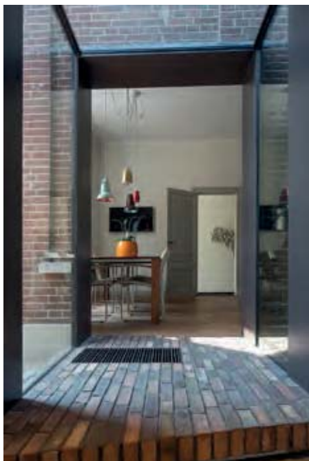
Der er anvendt den samme kulbrændte, røde sten til gulv som til de murede facader.
