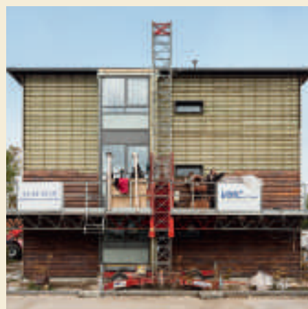
Tegnestuen Mangor og Nagel renoverer det almene boligbyggeri, Sydhavnen, i Slagelse, hvor de traditionelle murstensfacader udskiftes med den nye tag- og facadesten.
