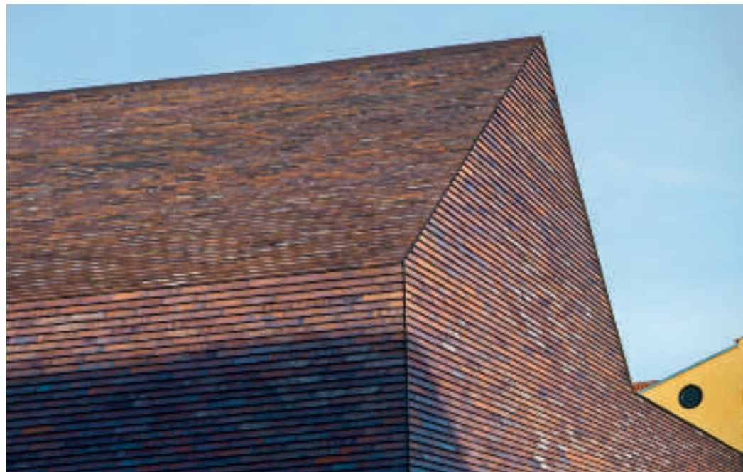
Lundgaard og Tranberg bearbejdede tilslutningerne i bygningen således, at hjørner og gavle fremstår helt præcise på trods af upræcisionen i de enkelte teglsten.
