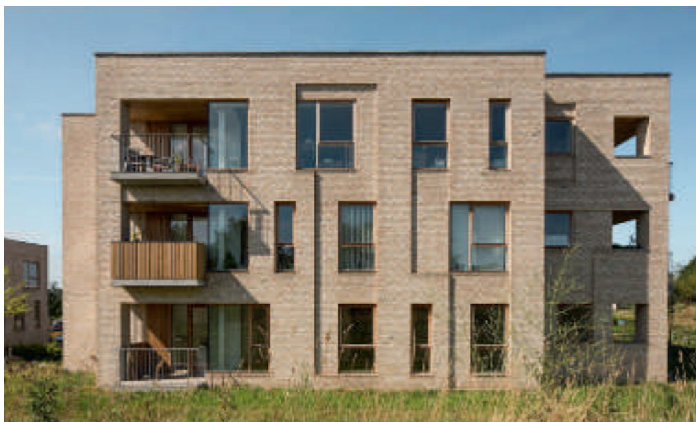
Murværket i facaderne er udført med forskudte lag og linjer i et varieret og asymmetrisk mønster. Foto: Anders Sune Berg
