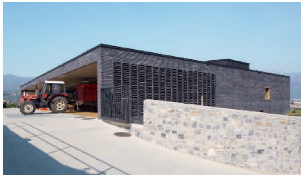
Det perforerede murværk er smukt, praktisk og betyder, at den overdækkede ankomstplads ikke medregnes til det bebyggede areal.
