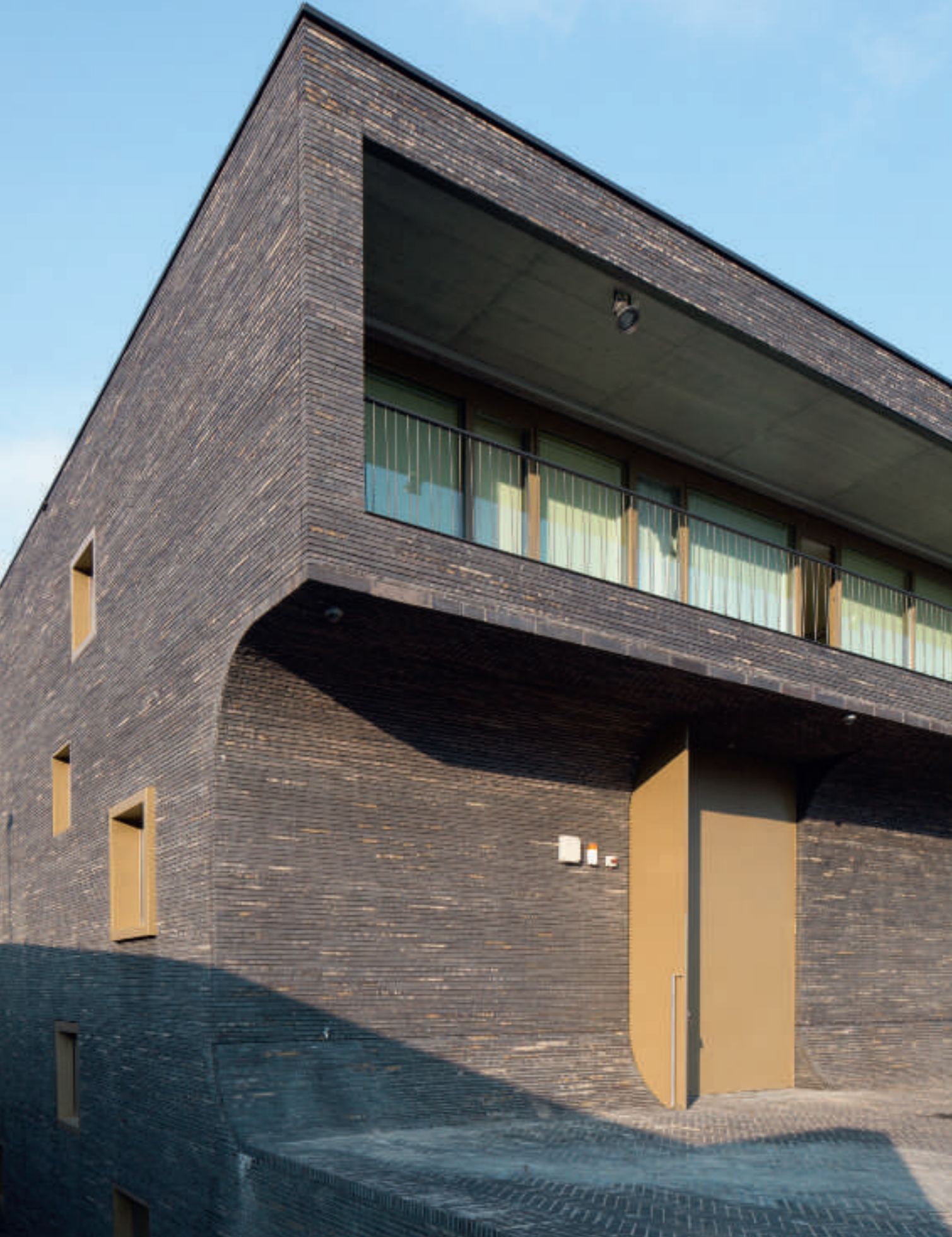
De specialfremstillede døre og vinduesindfatninger i anodiseret aluminium har den samme gyldne farve, der anes i murværket.
