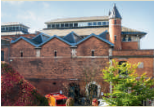
Elværket som det så ud inden tilbygningen.
