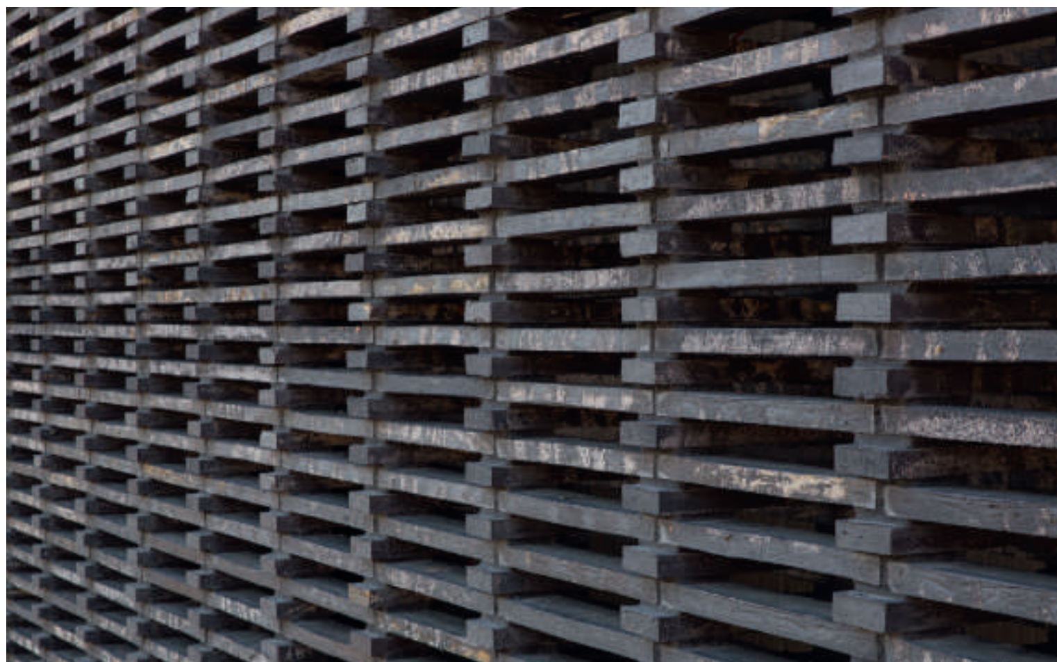
Kolumbas længde på 58 cm giver muligheder for et mønster i murværket, som ikke kan imødekommes af en almindelig mursten.
