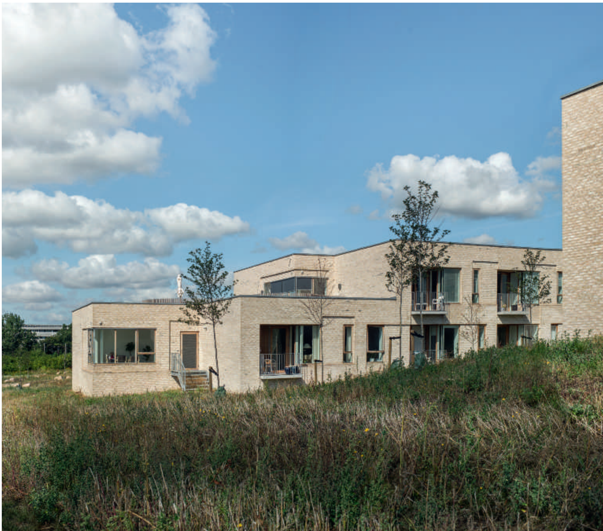
Det er en arkitektonisk bærende idé, at landskabet får lov til at strømme ind gennem bebyggelsen, og at bygningerne opleves som en forstærkning af landskabets kvaliteter. Det er derfor væsentligt, at de murede facader løber ned i terrænet uden sokkel. Foto: Jens Lindhe
