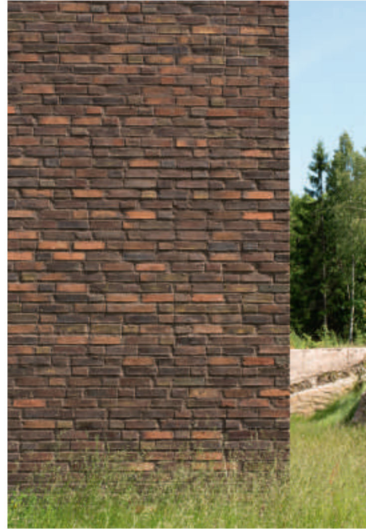
Det har stor betydning for oplevelsen af mødet mellem bygning og terræn, at de murede facader i et vildt forbandt går direkte ned i jorden.
