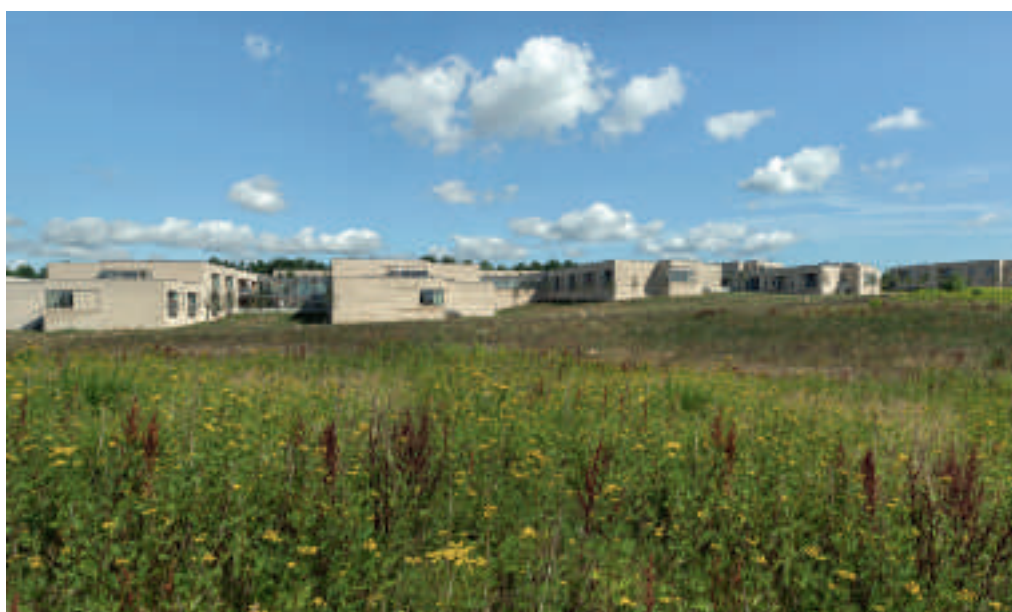
Det nye plejecenter er nænsomt placeret på grunden og indpasser sig i morænelandskabets faldende terræn. Foto: Jens Lindhe
