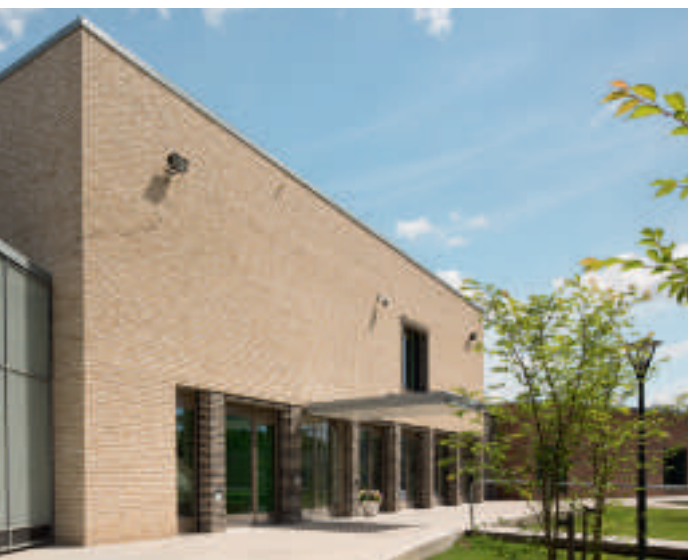
En enkelt bygning er udført med murede søjler i mørkegrå sten, der danner kontrast til den øvrige lyse facade.
