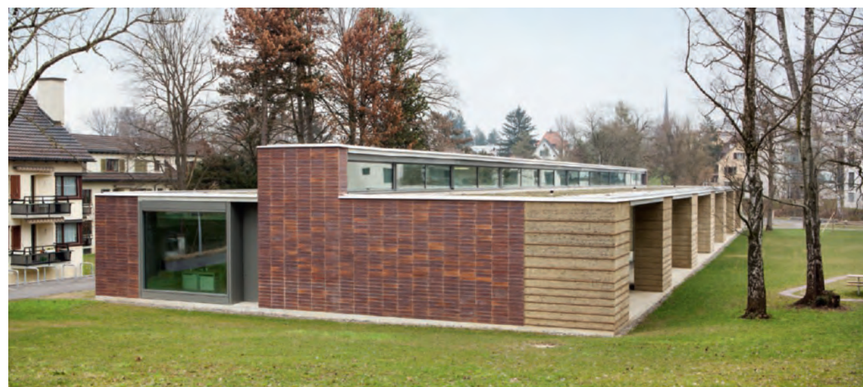
Boltshauser bad Petersen Tegl om at udvikle en 2 cm tyk klinke til husets facader. Klinken er klæbet direkte på den bagvedliggende isolering og udfuget i cementmørtel.
