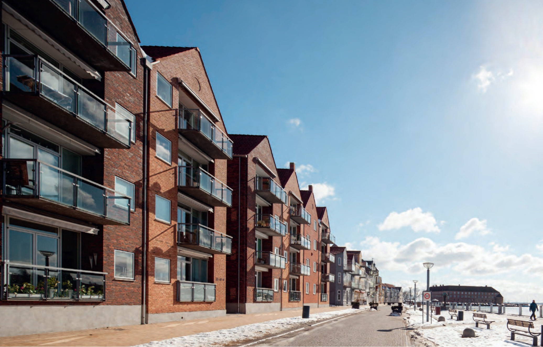
Bygningerne på havnekajen gentager gavlmotivet fra de øvrige huse i havnen. For at skabe variation er der anvendt forskellige farver mursten og mørtel i facaderne.
