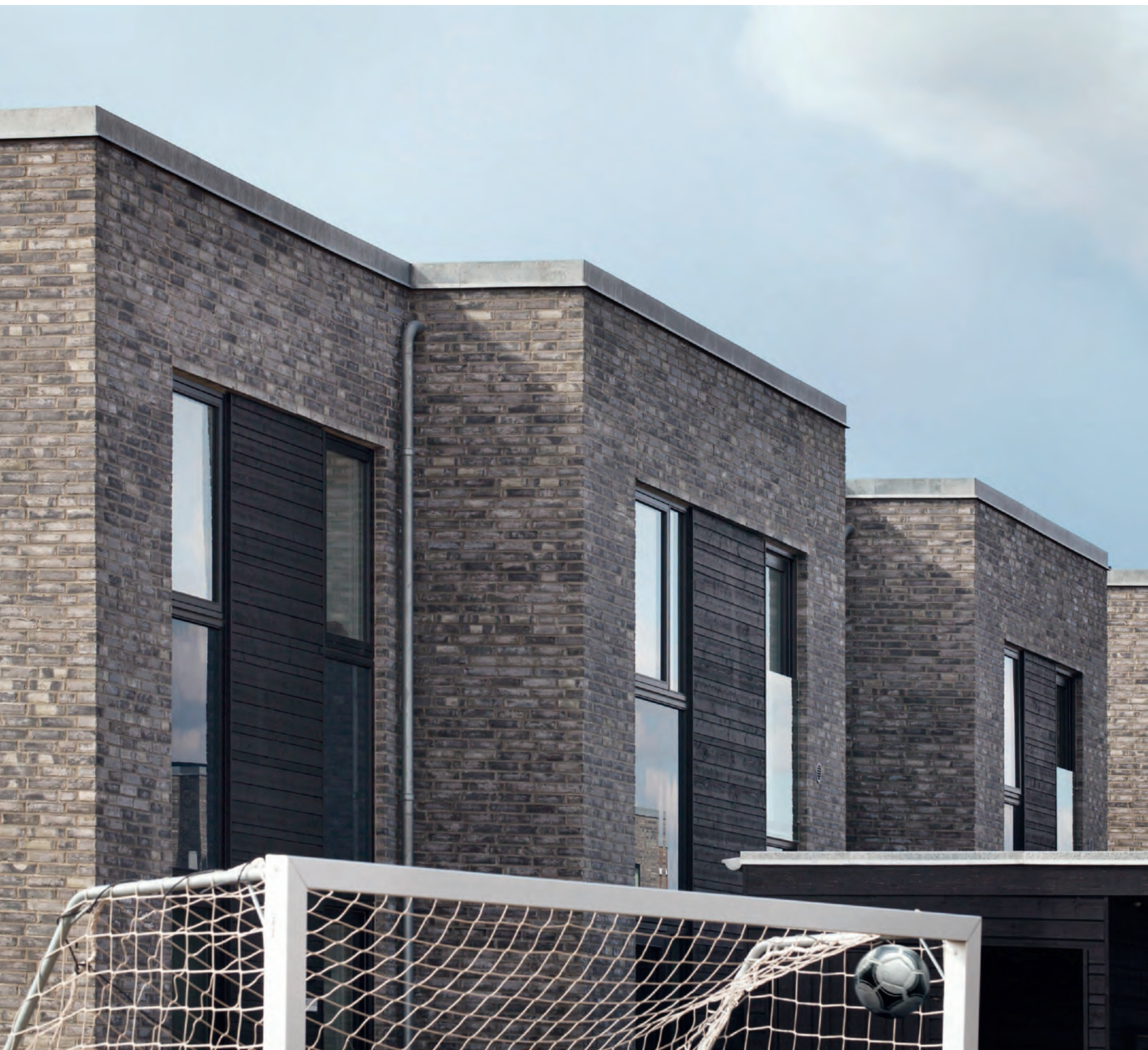
Almen boligbebyggelse Pilevangen, Århus – Foto: Anders Sune Berg
