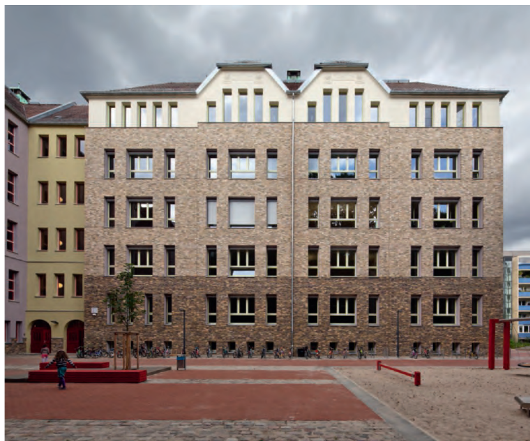
Facaden mod skolegården er beklædt med samme murværk som facaden mod gaden. Skolens øvrige facader blev pudset i nuancer, der genfindes i murværkets farver.
