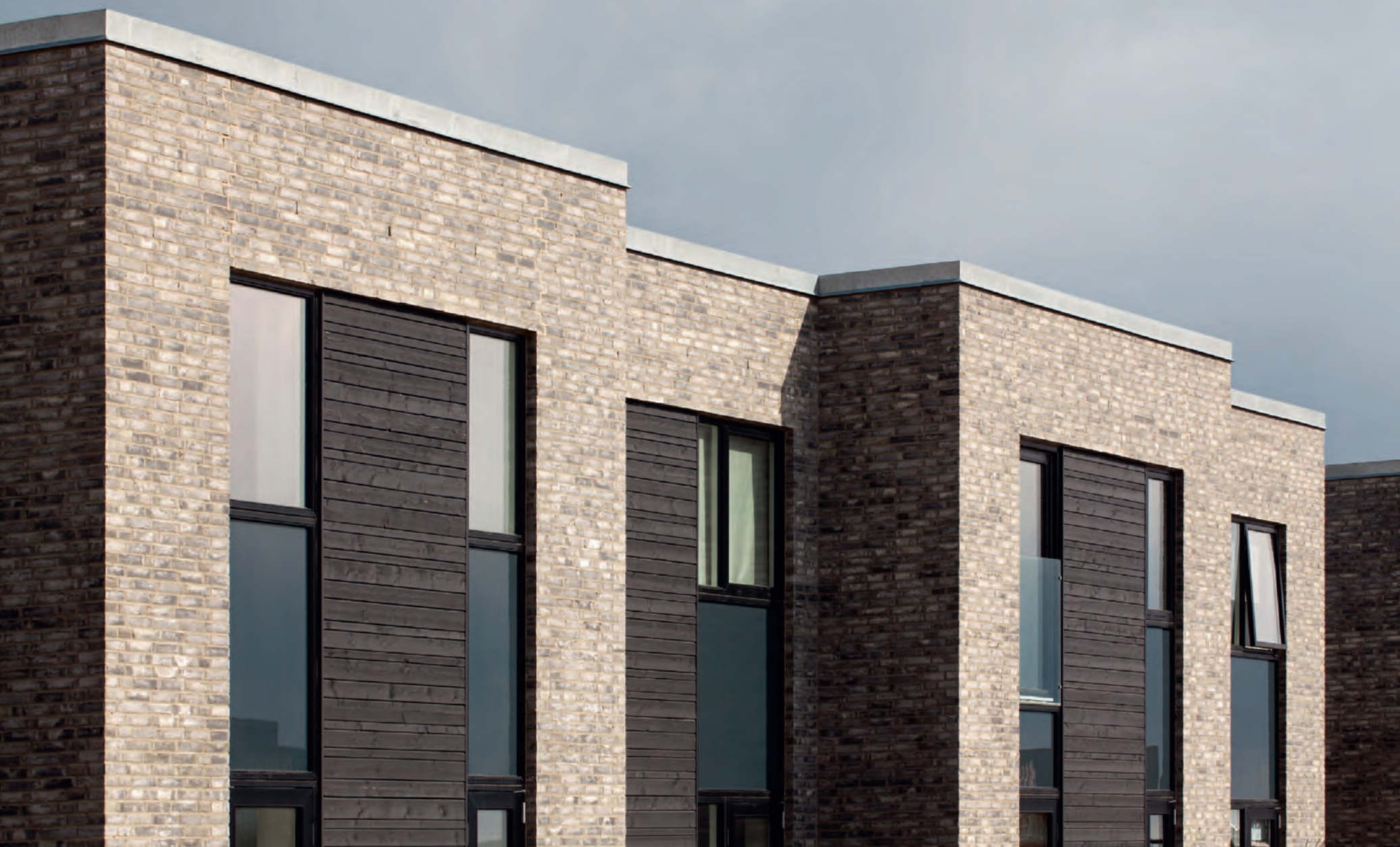
Rækkehusbebyggelsen Pilevangen i Solbjerg syd for Århus er opført med facader i blådæmpede mursten kombineret med sorte træpartier og aluvinduer. Boligerne er 80-114 m 2 store og indrettet i høj kvalitet.
