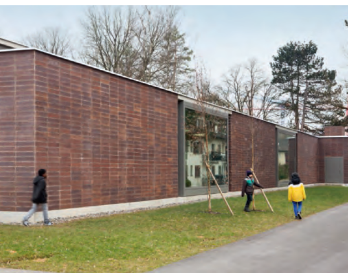
Fritidshjemets facade mod den offentlige sti fremstår kompakt og afskærmende, men i kraft af klinkerbeklædningens naturlige struktur og farve virker facaden ikke afvisende.
