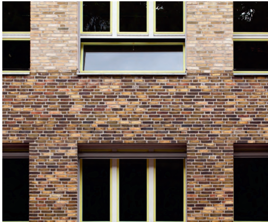
Bygningens sokkel er beklædt med den kulbrændte D47, der har et rigt farvespil med nuancer i brun, sort, rød, grøn og gul.
