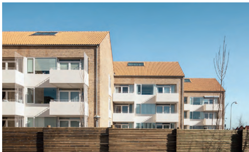
Det lykkedes at finde en ny mursten, der i farve og struktur matcher stenene i den 65 år gamle Bredalspark.
