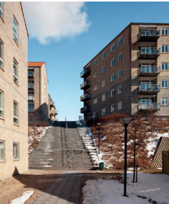
En bred sti forbinder havnekajen og Bjerggade i det centrale Sønderborg.
