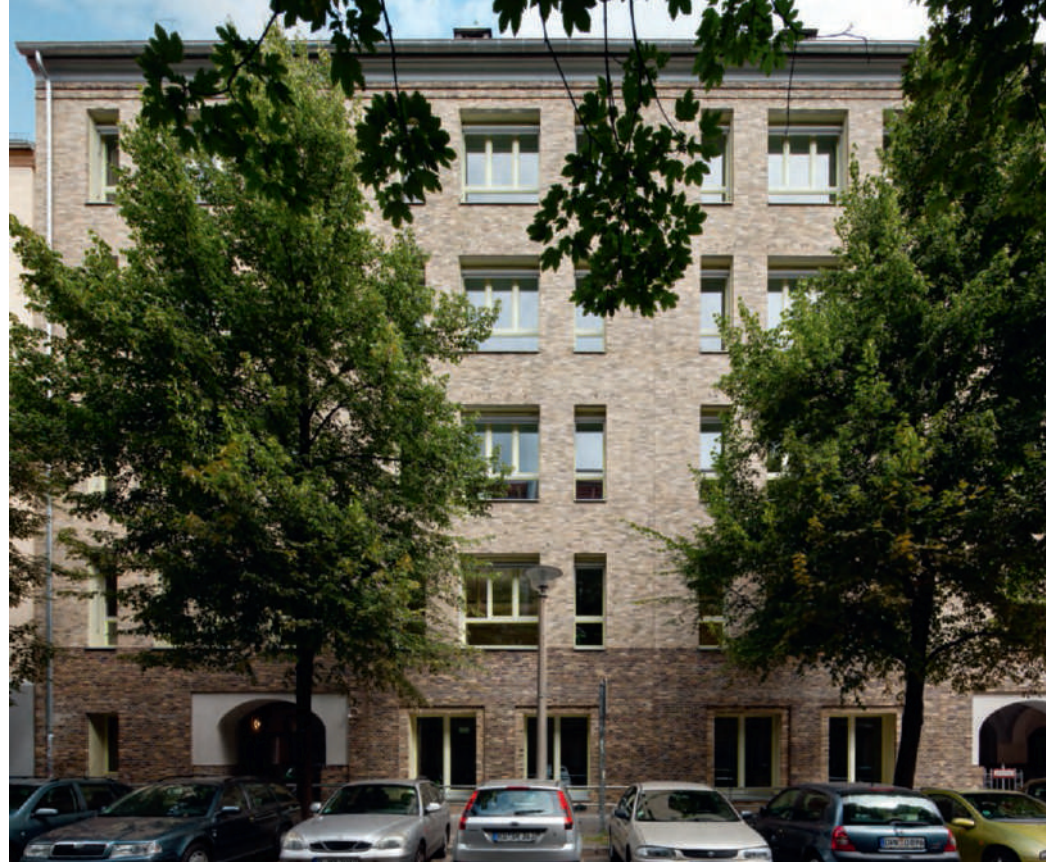
Som led i renoveringen er der opført nye skalmure mod Scharnweberstrasse.
